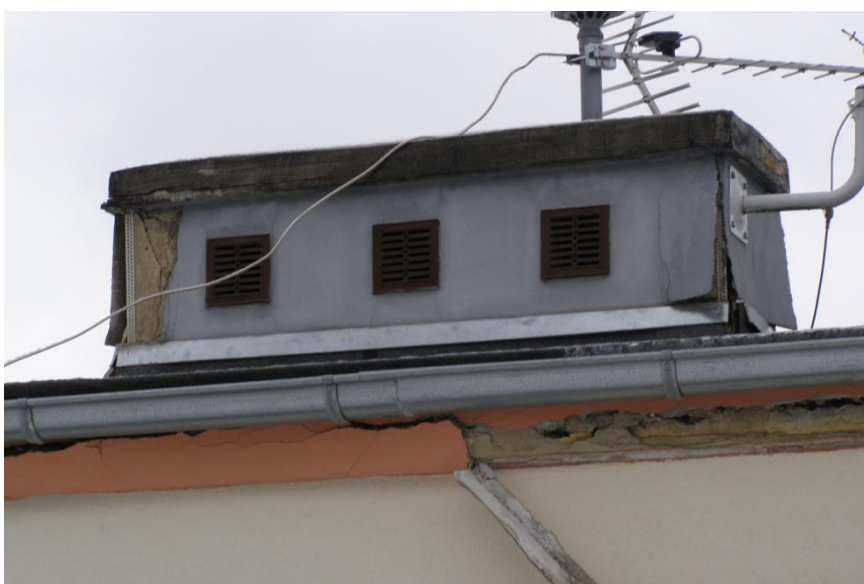
Zdjęcie 6. Ubytek tynku w okolicy komina i rynny (elewacja tylna).
