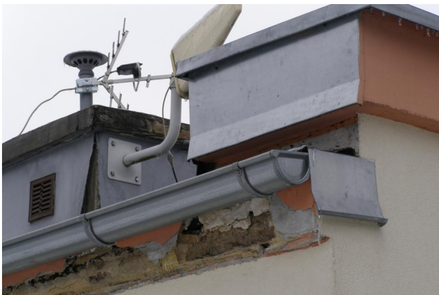
Zdjęcie 5. Ubytek tynku w okolicy komina i rynny (elewacja tylna).
